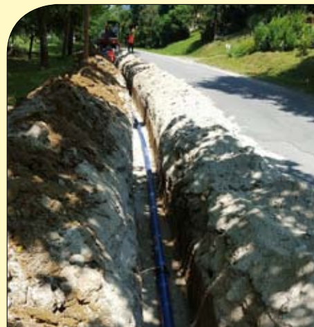
Zamenjava vodovodne cevi na Rudniški cesti
