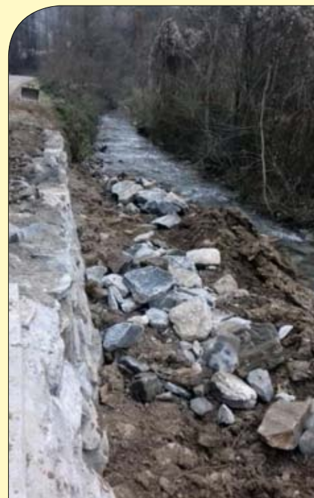
Sanacija brežine vodotoka v Loški Gori
