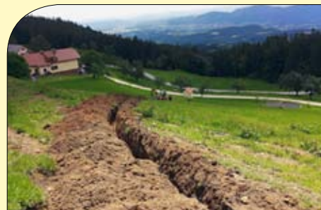
Izgradnja vodovodnega sistema na Planini
