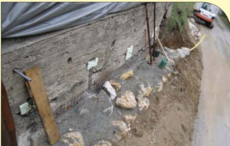
Izgradnja podpornega zidu
