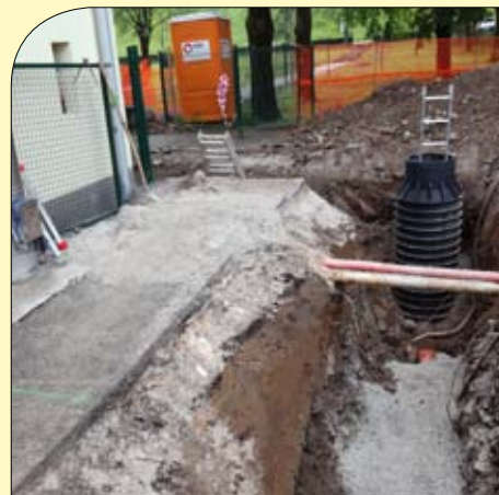
Izgradnja kanalizacije pri Osnovni šoli Zreče
