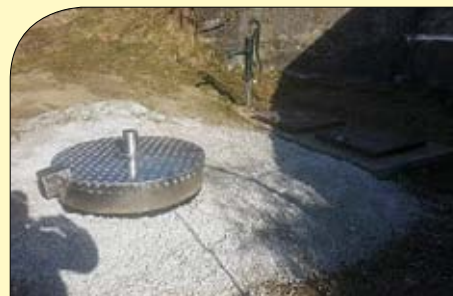
Črpalke črpališča Polajna
