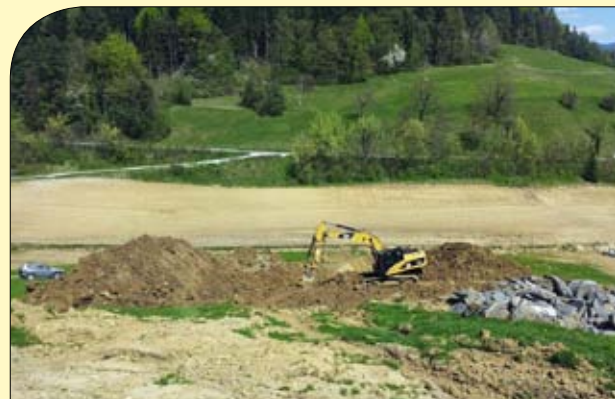
Sanacija plazu Konec
