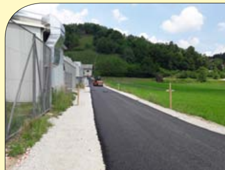
Izgradnja kanalizacije z obnovo ceste na območju Nove cone
