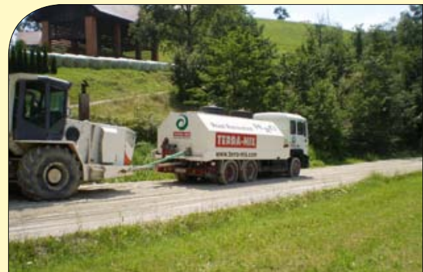
Obnova odseka lokalne ceste Zreče-Gračič-Malahorna
