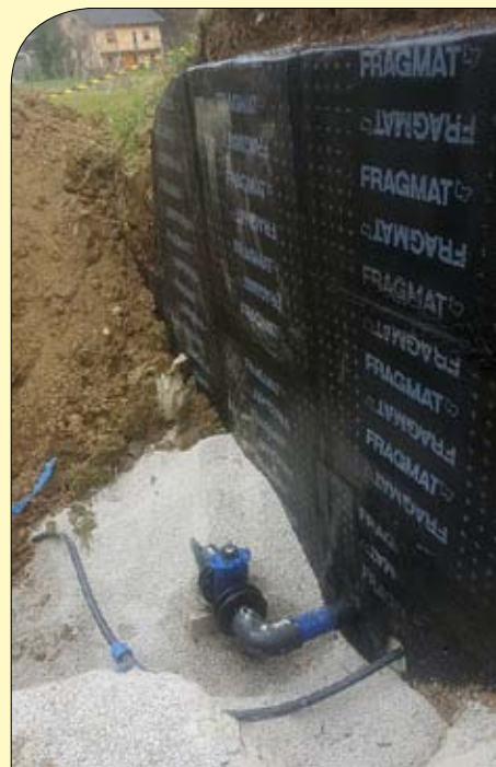
Obnova rezervoarja Grobovi
