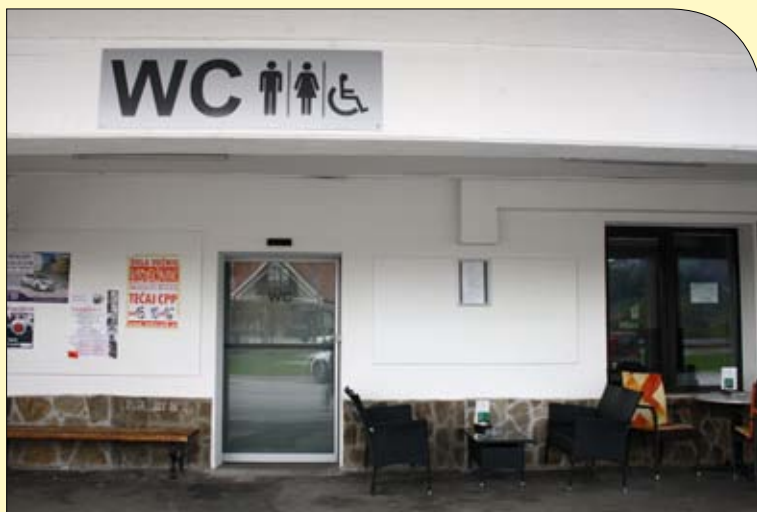
Obnovljene javne sanitarije na AP Zreče
