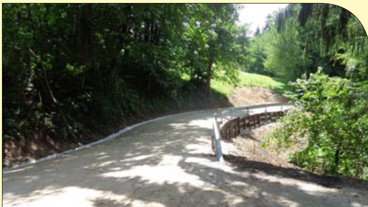
Območje sanacije plazu po izvedenih delih
