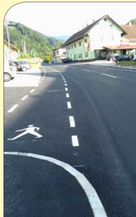
Rekonstrukcija Kovaške ceste v Zgornjih Zrečah
