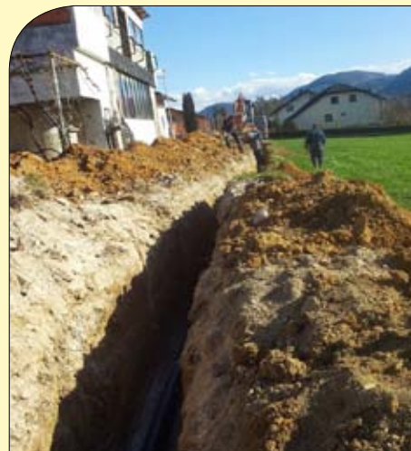
Zamenjava vodovodnih cevi v Ulici bratov Mernik
