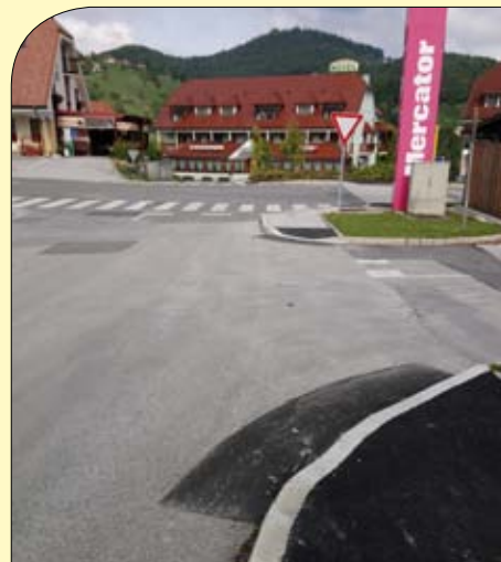
Izvedba del prilagoditev in poglobitev pločnikov
