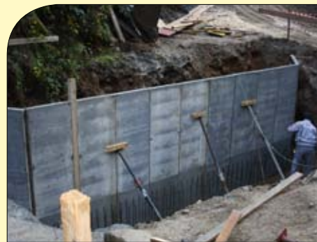
Pričetek izgradnje mostu na Ločnici
