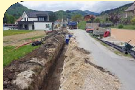
Obnova vodovodne cevi ob Ilirski poti
