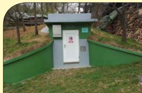
Obnovljen rezervoar Oprešnik
